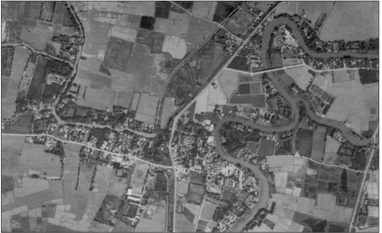
ภาพ ๖ ถ่ายทางอากาศ
